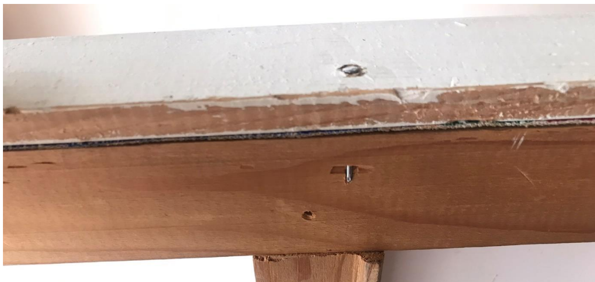
A védőkeretet rögzítő átszelés a kép alsó részén.
