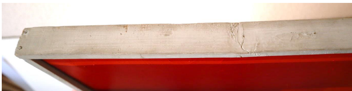
A védőkeretet rögzítő átszelés a kép alsó részén.
